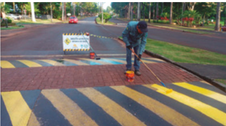
Pintura de lomada sobre la Avda. Paraná.
