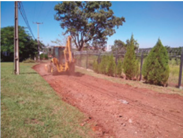
Regularización de calle sobre circunvalación.
