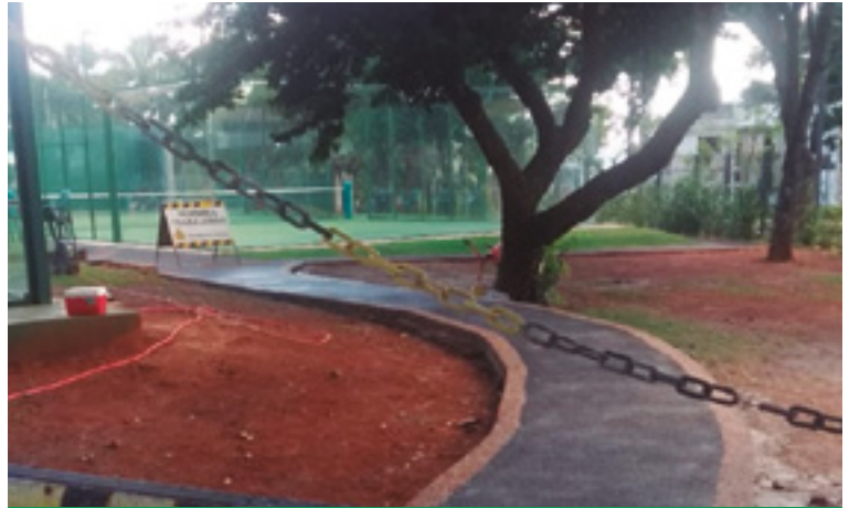
Caminero zona Cancha de Padel.
